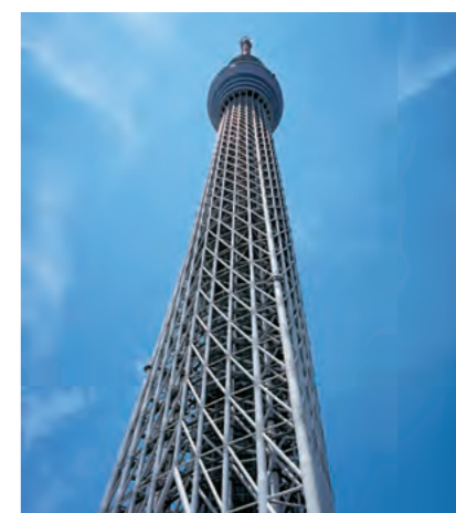
タワーの見上げ。足元の三角形頂部から伸びる柱はそりを、三角形の辺から伸びる柱はむくりを描く。
