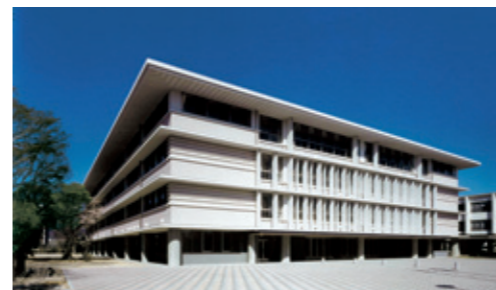
8_ 奈良文化高等学校 Nara Bunka High School
