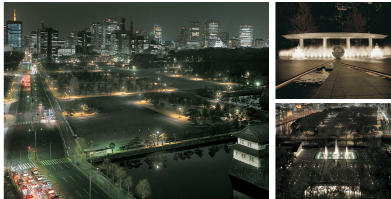
建築主 環境省自然環境局皇居外苑管理事務所 所在地 東京都千代田区
