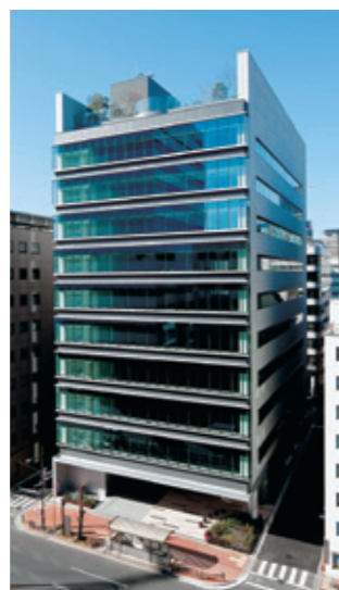
5_ 住友商事八重洲ビル Sumitomo Corporation Yaesu Building
