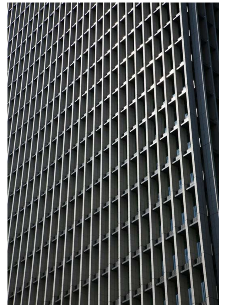
上：オフィス基準階。外周部の柱が日差しを制御しつつも、開放的な視界を確保している 下：ファサードの詳細。陰影ある表情が日本らしさと品格を醸成する
