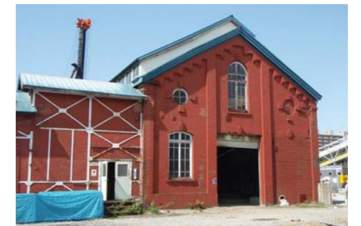
煉瓦造工場遺構の外観
