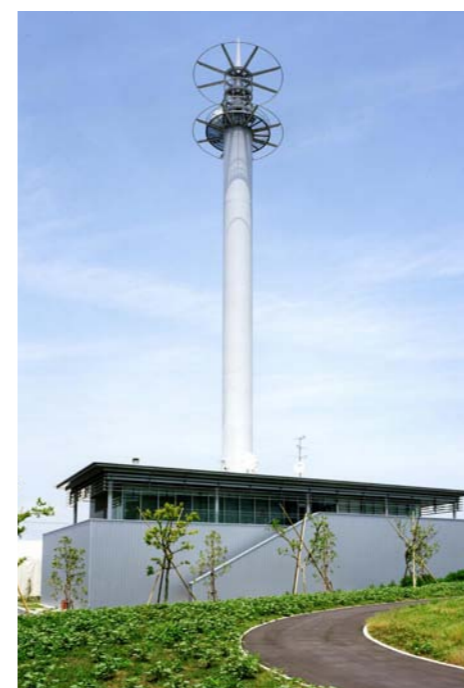
東扇島基幹的広域防災拠点施設*
