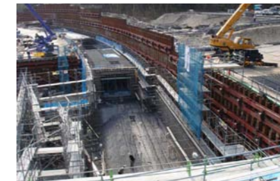
50GeV加速器トンネル(工事中の状況、2006.3.9撮影)。遮蔽厚2~5mに及ぶ鉄筋コンクリート造のトンネル断面
