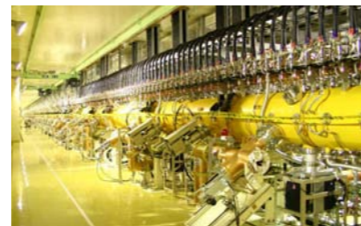
リニアック加速器トンネル(2007.10.16撮影)
