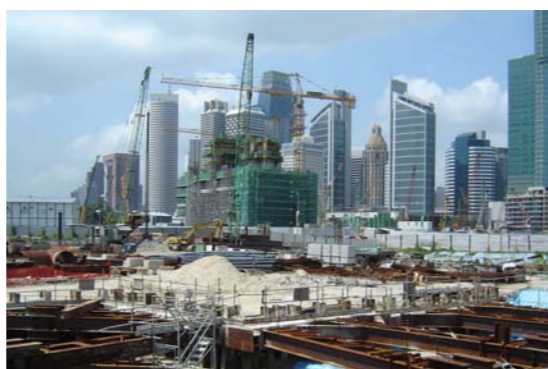
共同溝サイトから新都市開発エリアを望む
