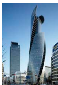
モード学園スパイラルタワーズ 社会領域—公共施設・建築
