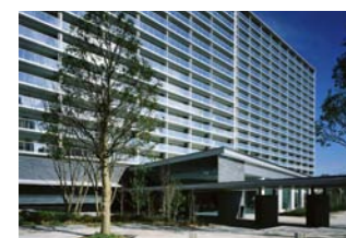
シティテラスさいたま新都心 (日建ハウジングシステム) 集合住宅
