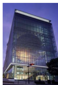
千葉中央市街地再開発ビル ぎぼーる千葉中央 社会領域—公共施設・建築
