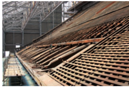
軒先の不陸調整が完了した上層屋根下地。屋根の上から順に土居萱板、木小舞、野垂木と構造梁枯木。
