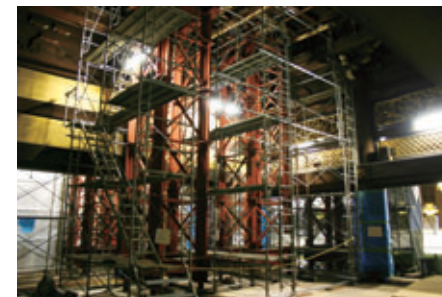
損傷柱や梁補修のため屋根荷重を鉄骨仮設支保工によって仮受け。鉄骨は梁下と地盤の間に設ける。
