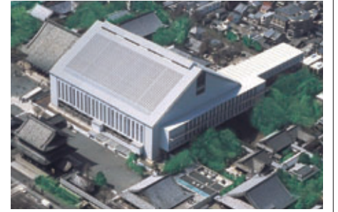
仮設素屋根は美観地区内に建設された。天窓、換気用暖屋根、換気用スリット窓、太陽光発電、雨水利用。
