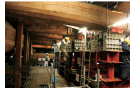
仮設支保工の柱頭部分でのジャッキ取り付け作業。36台のジャッキを慎重に制御しつつ17時間連続で実施。
