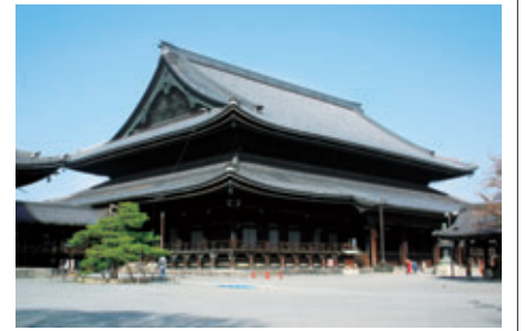
御影堂修復前。
