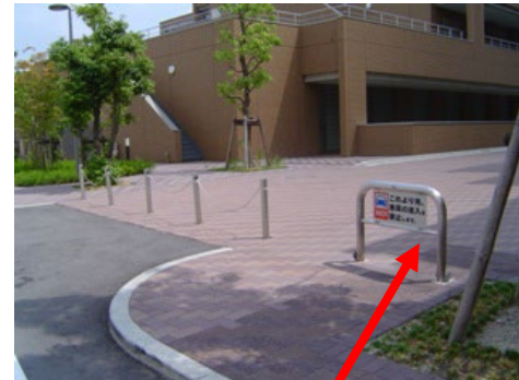
■車両進入防止柵 可動埋込み式(左)と取外し式(右)
