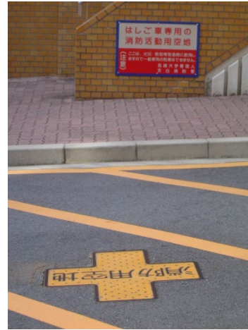
■消防活動空地 標示は所轄消防署により異なる
