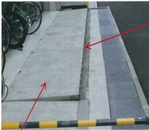
<地震後の可動床の変形>
