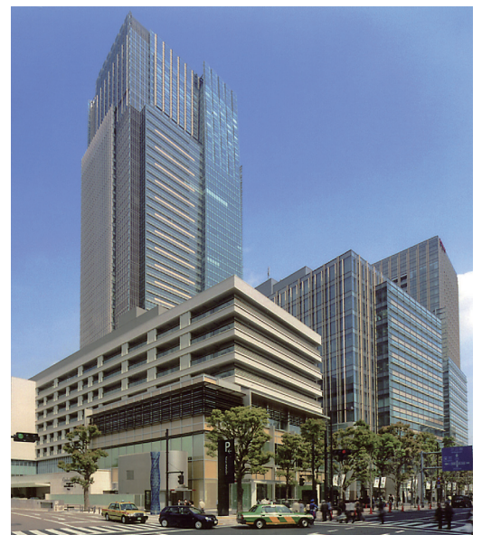
複合用途施設実施事例 東京ミッドタウン
