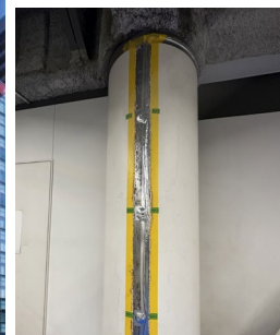
ひずみセンサ 取付状況（柱部分）
