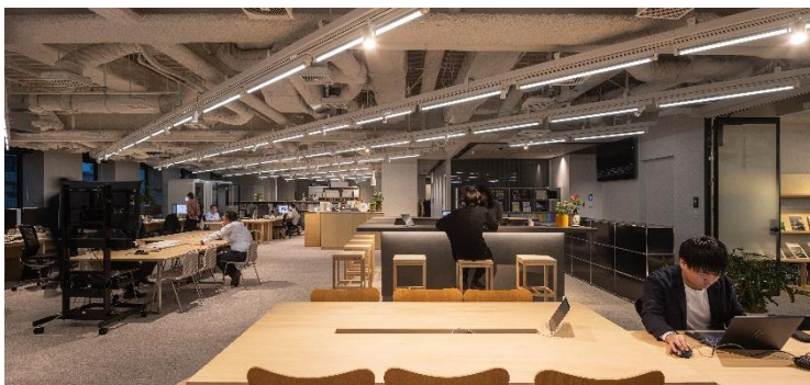
<照度を抑えつつ、必要な場所にスポットライトを組み合わせることにより、必要な明るさを確保した執務空間 (撮影：石井紀久/ブリッツスタジオ)>
