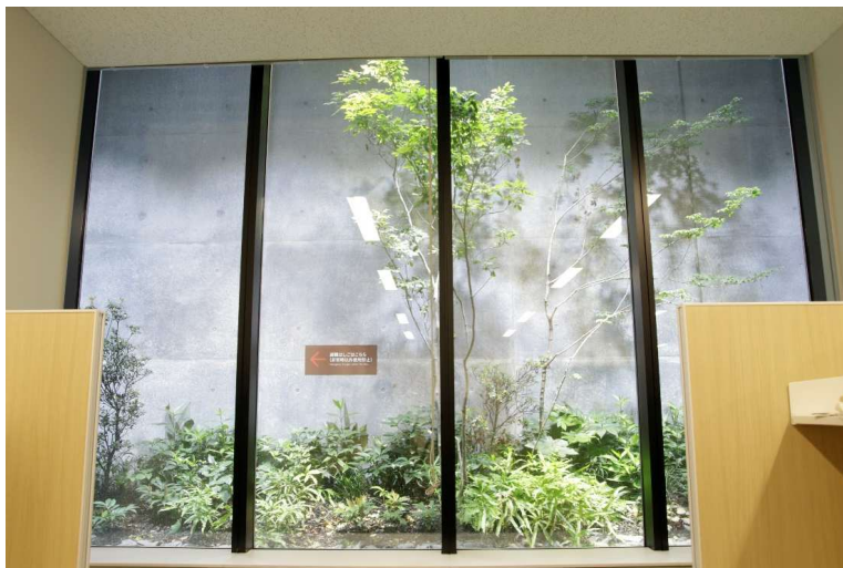
地下空間に設置した自然光模擬照明（左：点灯時、右：消灯時）
